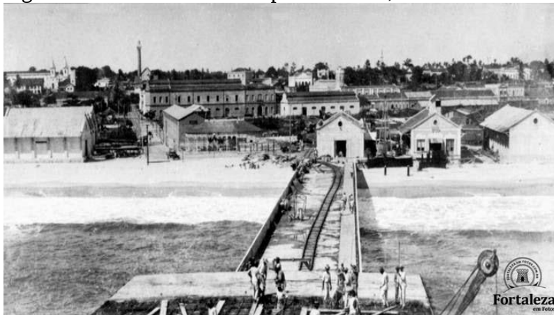
Figura 1 – Última reforma da ponte do cais, início do séc. XX.
