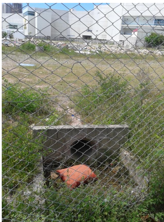
Figura 20: Caixas coletoras implantadas dentro do terreno do shopping, necessitam de manutenção constante Crédito da foto: Acervo do Autor
