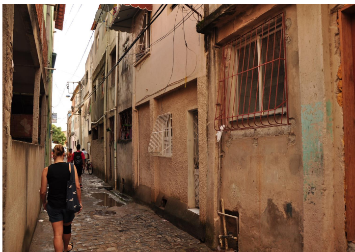
Figura 12 (foto: acervo da pesquisa). Vias estreitas. Na maioria não há diferenciação entre via de pedestre e de veículo, não há recuo das construções em relação à via: janelas e portas “de olhos na rua”. Possibilidade de condições insalubres das habitações.
